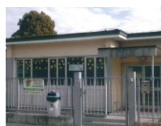
14_Scuola elementare Geromina e palestra
