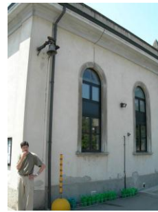
22_Uffici presso cimitero Via Abate Crippa
